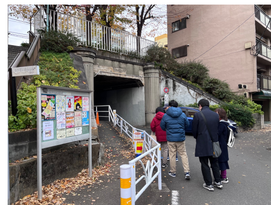
公園の下にあるトンネル（本村隧道）
