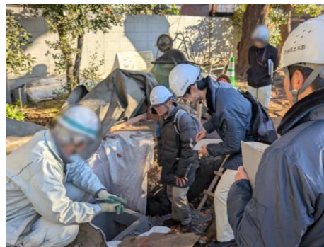
大山緑道にて現場を見ていただいている様子
