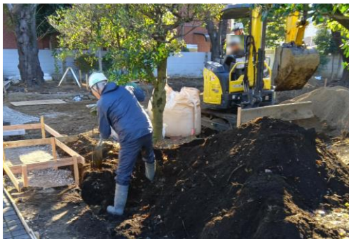
人力で探り掘りを実施している様子
