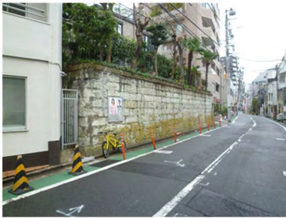
<沿道の擁壁部分>
