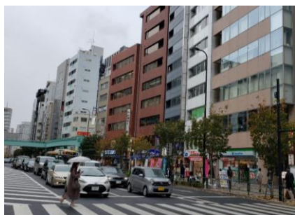
明治通り沿道の建築物
