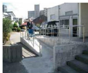
①スロープの設置
