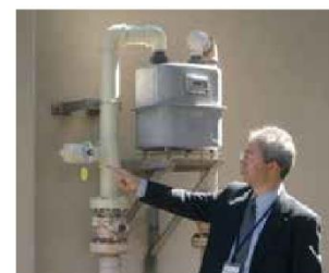
⑤LP ガスから都市ガスへの変換器の接続口
