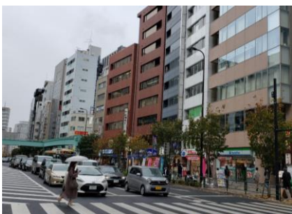
明治通り沿道の建築物
