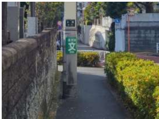
歩道通行の支障となる電柱
