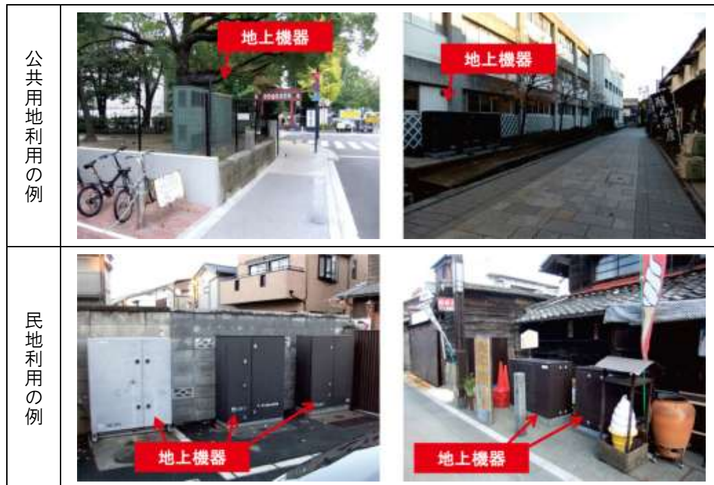
参考写真-2 地上機器の設置場所の例
