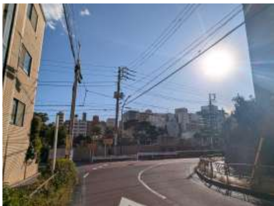
景観上支障となる電柱・電線
