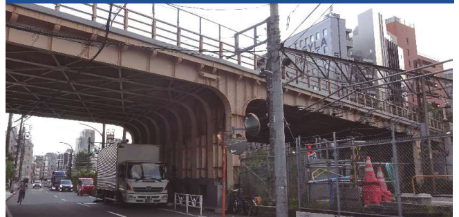
全体(橋の下から)
