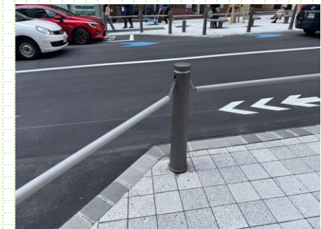
横断抑止柵は支柱・ビームとも取外し可
