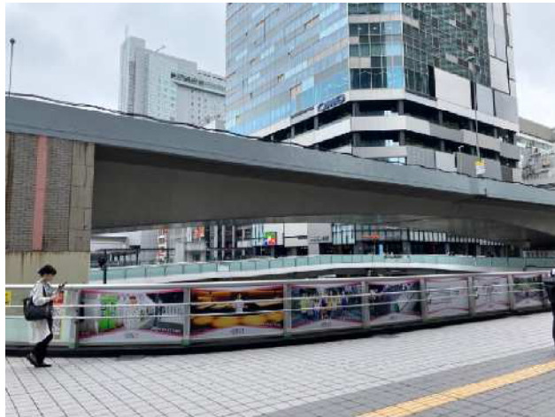
西口国道デッキシート
