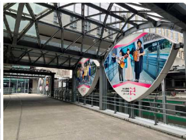
ストリーム2Fデッキシート
