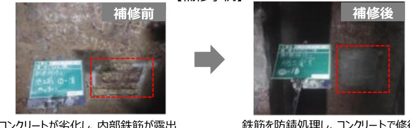
コンクリートが劣化し、内部鉄筋が露出
