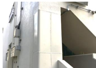
1階柱の耐震改修(実施済み)
