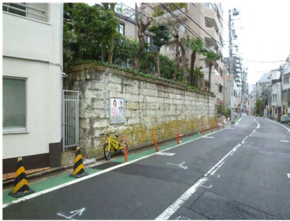
<沿道の擁壁部分>
