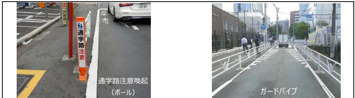
【図17】局所的な安全対策の整備例
