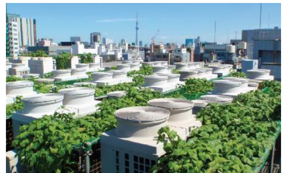
* 1 : 空調機上の芋緑化システム
