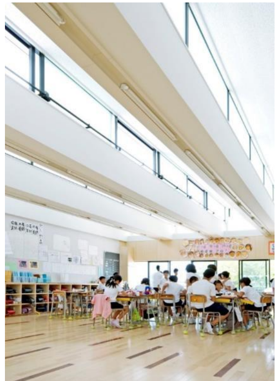
快適な採光：高窓からの採光で明るい校舎の事例 鈴鹿市立 旭が丘小学校
