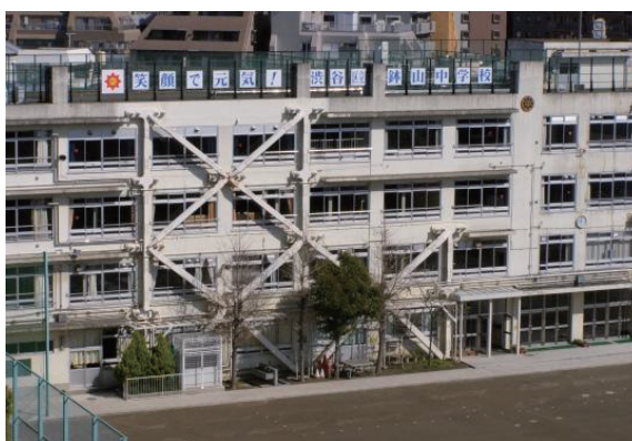
渋谷区立鉢山中学校 耐震改修工事後
