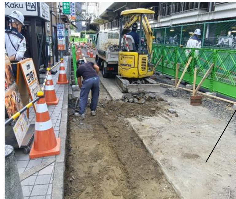
笹塚緑道 掘削状況
