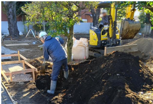
人力で探り堀りを実施している様子
