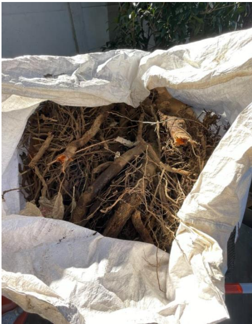
大山緑道工事現場 該当写真
