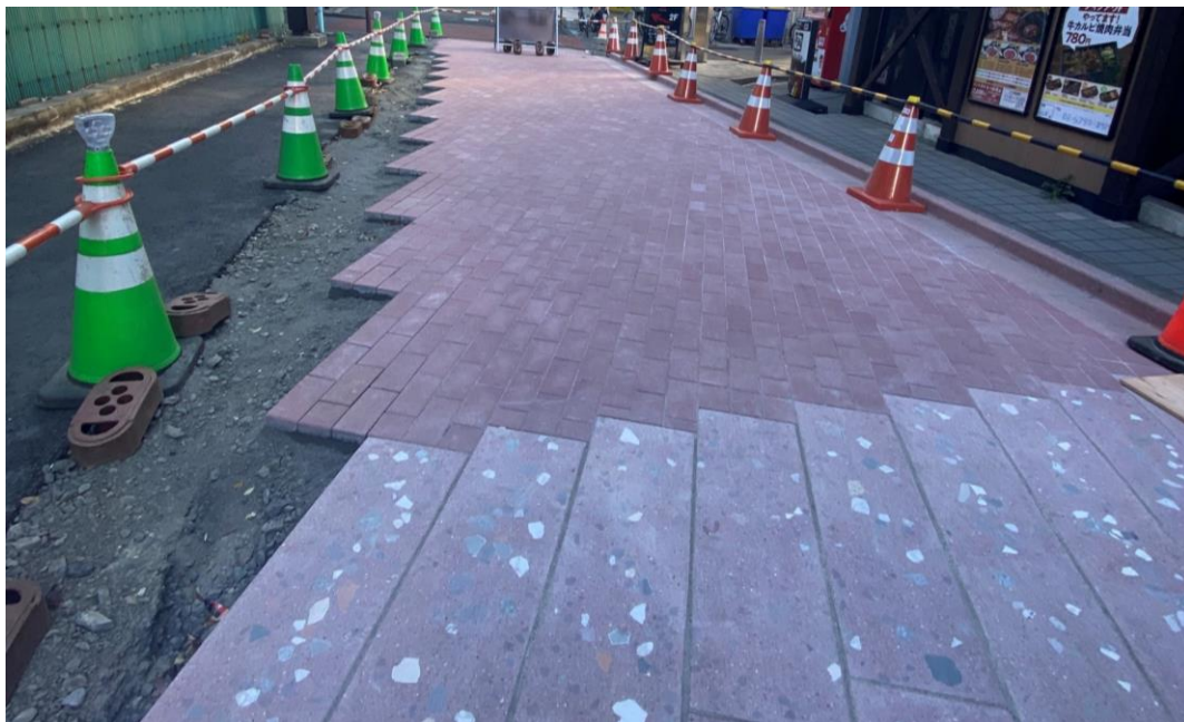
笹塚緑道 インターロッキングブロック舗装敷設箇所
