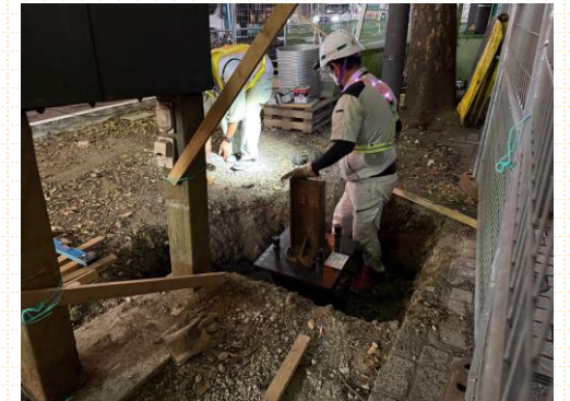
設置された杭基礎：図面通りの位置、深さに打ち込めているか入念にチェック
