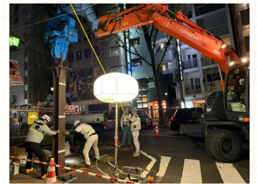
街路灯の杭基礎工事の様子：車両感知器や電線など道路上の構造物を避けながら施工
