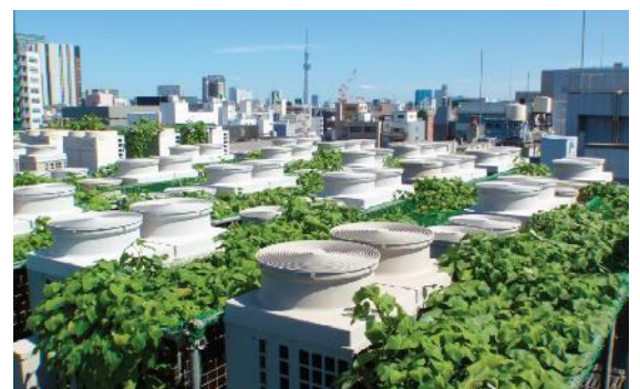
* 1 : 空調機上の芋緑化システム
