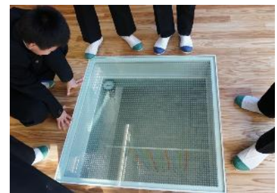
クールヒートレンヂピット観察窓に温度計とリボンを設置して、風と温度を見える化する工夫
