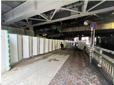
JR高架下沿道
