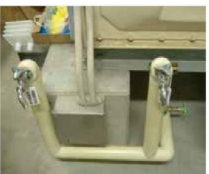
④受水槽への蛇口の設置
