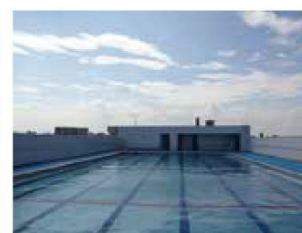
⑧屋上に設置したプール
