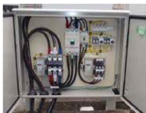
④発電機の取付口 (江戸川区提供)
