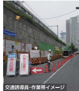
交通誘導員・作業帯イメージ
