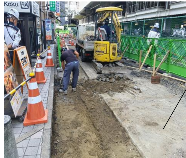
笹塚緑道 掘削状況
