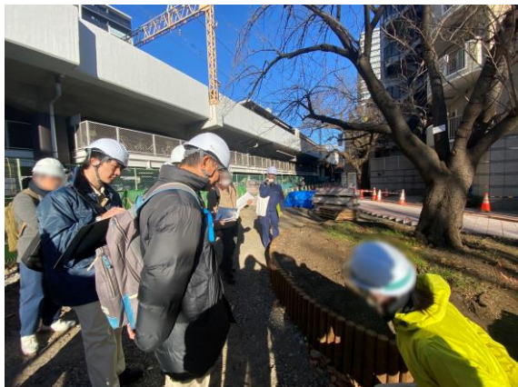
笹塚緑道にて現場を見ていただいている様子
