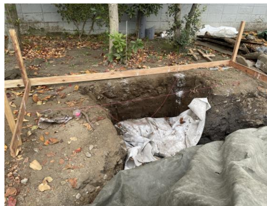
大山緑道 浸透ます設置箇所の現場状況 (令和6年12月撮影)
