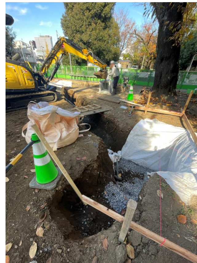
大山緑道 浸透ます設置箇所の現場状況 (令和6年12月撮影)
