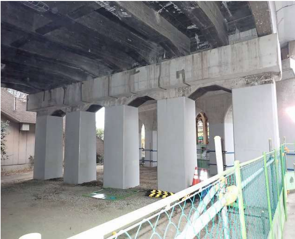
コンクリート橋
